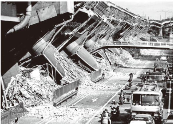
【阪神・淡路大震災】橋脚もろとも横倒しになった阪神高速道路神戸線＝1995年1月17日、神戸市東灘区深江本町（いずれも神戸新聞社提供）
