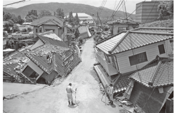
【熊本地震】2度の激震で倒壊した家屋 = 2016年5月、熊本県益城町
