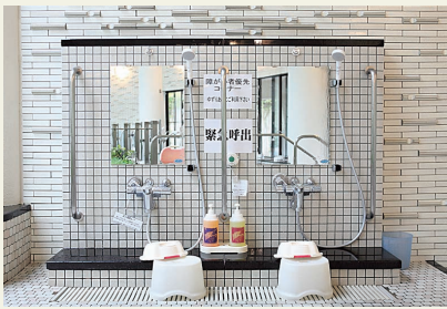
浴槽の入り口には手すりやスロープをつけて滑らない工夫を。障がい者優先のシャワーブースもある。車イスのまま入浴できる個室の介護浴室は予約制。
