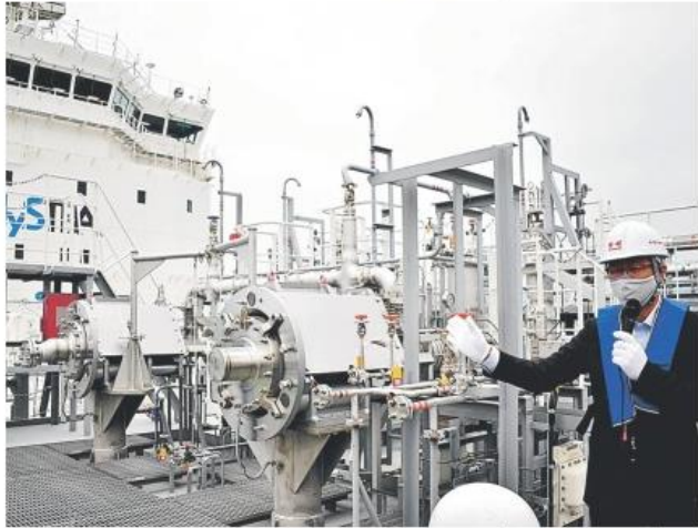
運搬船の甲板にある液化水素をタンクに移すための設備＝24日午前、神戸市中央区神戸空港
