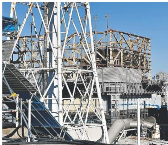
水素爆発が起き、鉄骨がむき出しのままの福島第1原発1号機＝4日午後、福島県大熊町（代表撮影）
