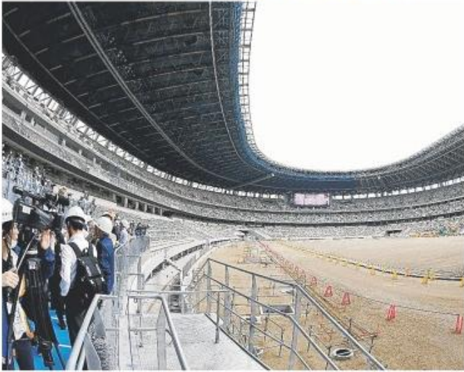
報道陣に公開された新国立競技場の建設現場
