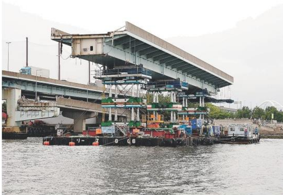
台船に積んだジャッキで持ち上げられ、慎重に撤去される鳴尾橋の橋桁。2日午後、西宮市（撮影・斎藤雅志）
