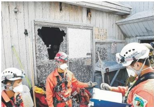
東京消防庁が撮影した、壁やガラスが破損した御嶽山山頂付近の山荘の様子＝2014年9月（同庁提供）
